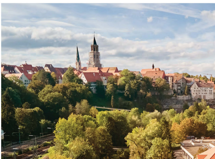
Blick von der Wehr in Richtung Brücke
